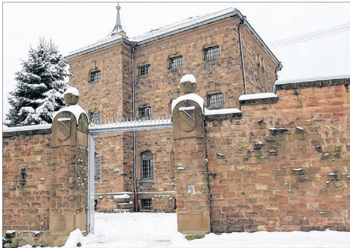
Die ehemalige Jugenddarrestanstalt in Wiesloch soll bald als Einrichtung zur „Therapieunterbringung“ entlassener Gewalttäter genutzt werden. Doch wird dort jemals ein „Patient“ einziehen? In der Stadt regt sich Widerstand. Foto: dpa
