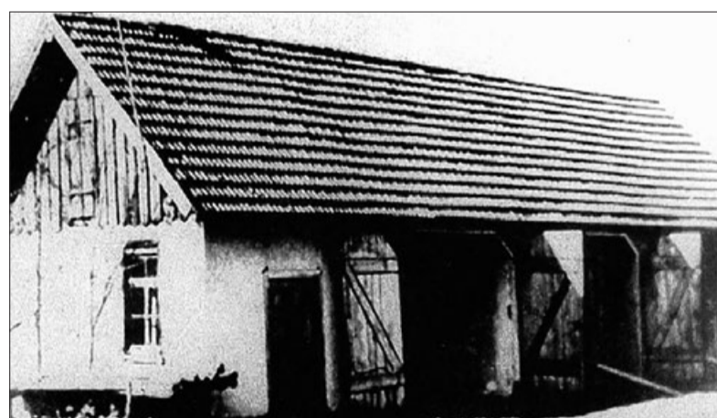
In diesem Schuppen wurden in Grafeneck die geistig behinderten und psychisch kranken Menschen durch Kohlenmonoxid-Gas getötet. Foto: Archiv Grafeneck
